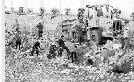
为了提高河道的防洪能力,确保河道两岸群众和企业防洪安全,新郑市今年赶在主汛期前,投资600万元对黄河上游城区段890米河段进行了防洪除涝综合治理。本报记者 许大桥 通讯员 郑宏伟 摄
