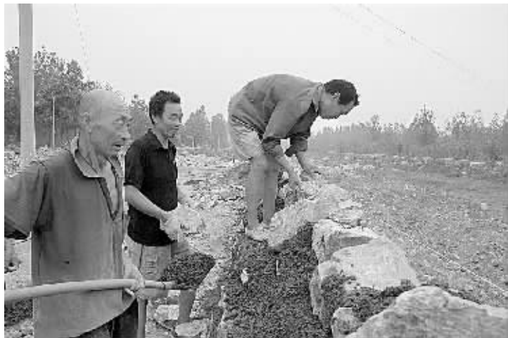
大金店镇以创建郑州市卫生乡镇为契机扮靓市区“西大门”,加大环境整治力度,进一步改善镇区人居环境。目前,该镇镇区道路硬化920米,其中沿河公路、市场改造、河堤维护治理三大工程已经完成80%,镇区面貌有了明显改变,图为施工人员筑筑镇区滨河河堤。
