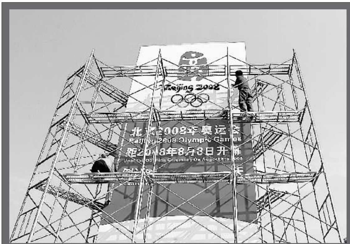
8月6日,施工人员在银川市光明广场搭建2008年奥运会倒计时牌。倒计时牌高10.5米、宽3.4米,为正三面巨型钢结构。目前,倒计时牌施工已接近尾声,将于8月8日正式启用。新华社记者王鹏摄
