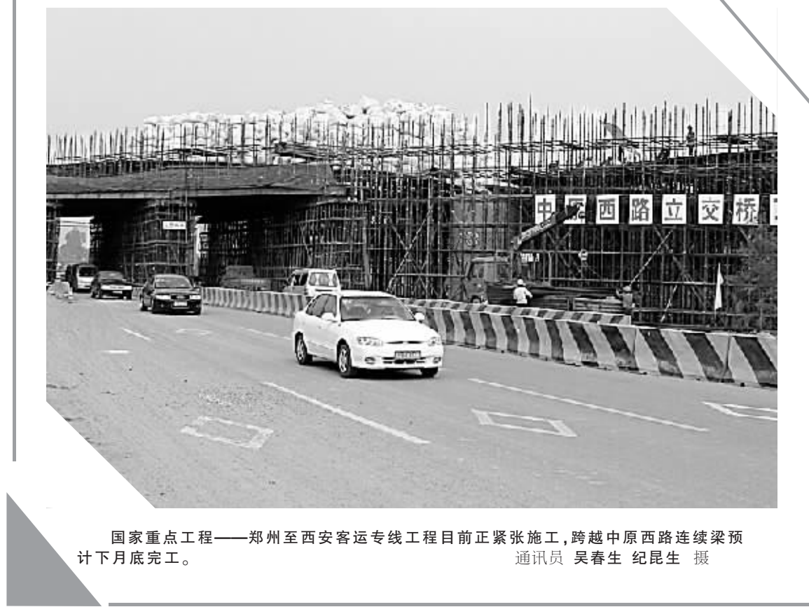
国家重点工程——郑州至西安客运专线工程目前正紧张施工，跨越中原西路连续梁预计下月底完工。
