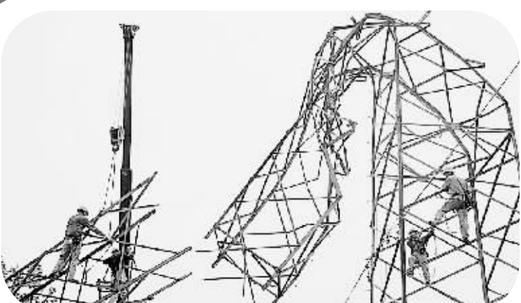
8月7日,江苏省泰州市高港区遭遇龙卷风袭击,造成4座110千伏高压供电铁塔损毁,1200多户村民家中断电。
