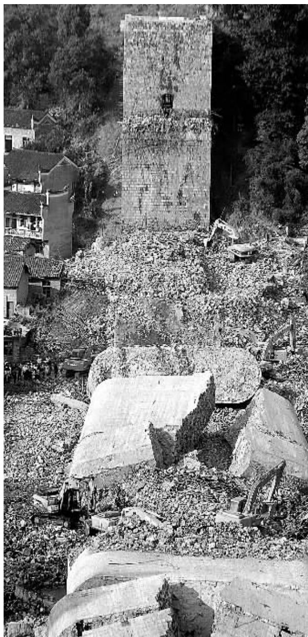
大桥坍塌事故现场。
