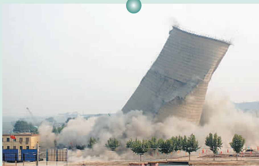
8月15日,在陕西省政府召开的“上大压小”关停小火电机组现场会上,大唐渭河发电厂2x5万千瓦的小火电机组被现场爆破拆除。2007年1至7月,我国已关闭695万千瓦能耗高、污染重的小火电机组,完成全年计划任务的近70%。这是小火电机组爆破瞬间。 新华社发
