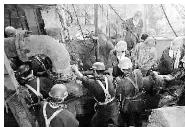
8月22日,经过3昼夜紧张安装,河南矿山抢险救灾中心支援山东溃水事故抢险工作的两台大功率水泵开始排水,每台排水量可达1000立方米/小时。 新华社发
