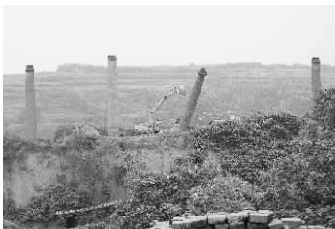
昨日下午,伴随巨大的爆破声,新密市米村镇茶庵村12座石灰窑轰然倒地。至此,该市今年应关闭的石灰窑已提前关闭到位。当天,有关部门还对超化镇楚岭村5座铝石窑的5根烟囱进行拆除(如图)。本报记者 成燕 通讯员 郑淑敏 王令 摄
