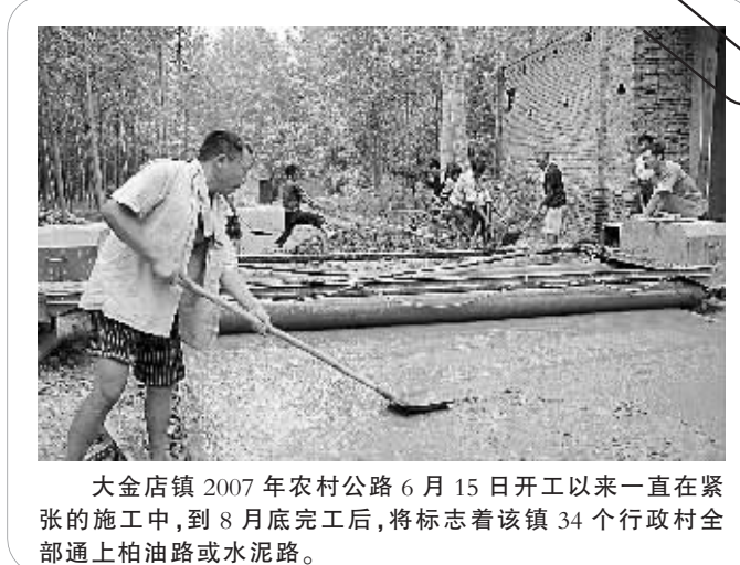
大金店镇2007年农村公路6月15日开工以来一直在紧张的施工中,到8月底完工后,将标志着该镇34个行政村全部通上柏油路或水泥路。
