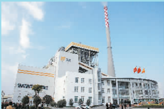
河南华润电力登封开发有限公司外景
