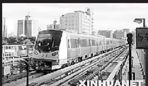
10月7日,地铁5号线列车驶入大屯路东站长站,北京地铁5号线正式开通试运营。
