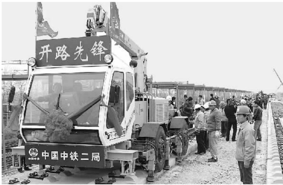
11月13日,中铁二局施工车辆在给京津城际快速铁路铺轨。当天,京津城际快速铁路在天津杨村开始铺轨。京津城际快速铁路是2008年北京奥运会重点配套工程,全长115公里,2005年7月4日开工建设,将于今年完成轨道工程,明年一季度试运行,将是中国最早建成的第一条设计时速350公里的高标准铁路客运专线。新华社发
