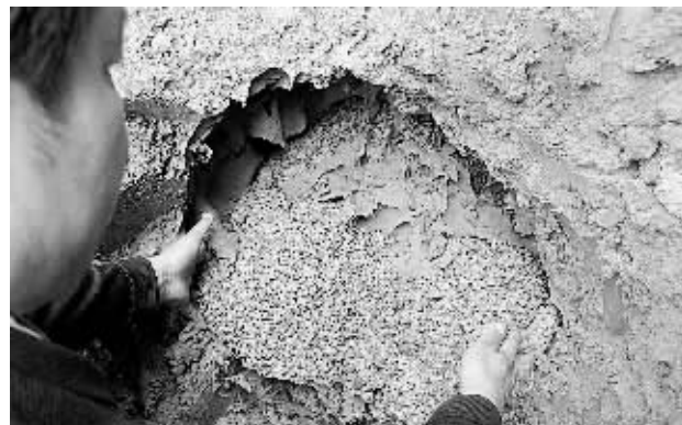
20日,白蚁防治人员挖出一个巨大的白蚁巢。当日,安徽省巢湖市的白蚁防治人员来到居巢区小阪塘水库堤坝上围剿白蚁,消除堤坝安全隐患。新华社发
