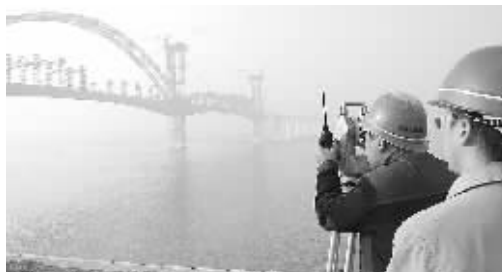
宜昌长江大桥巨型钢管拱吊装完成
