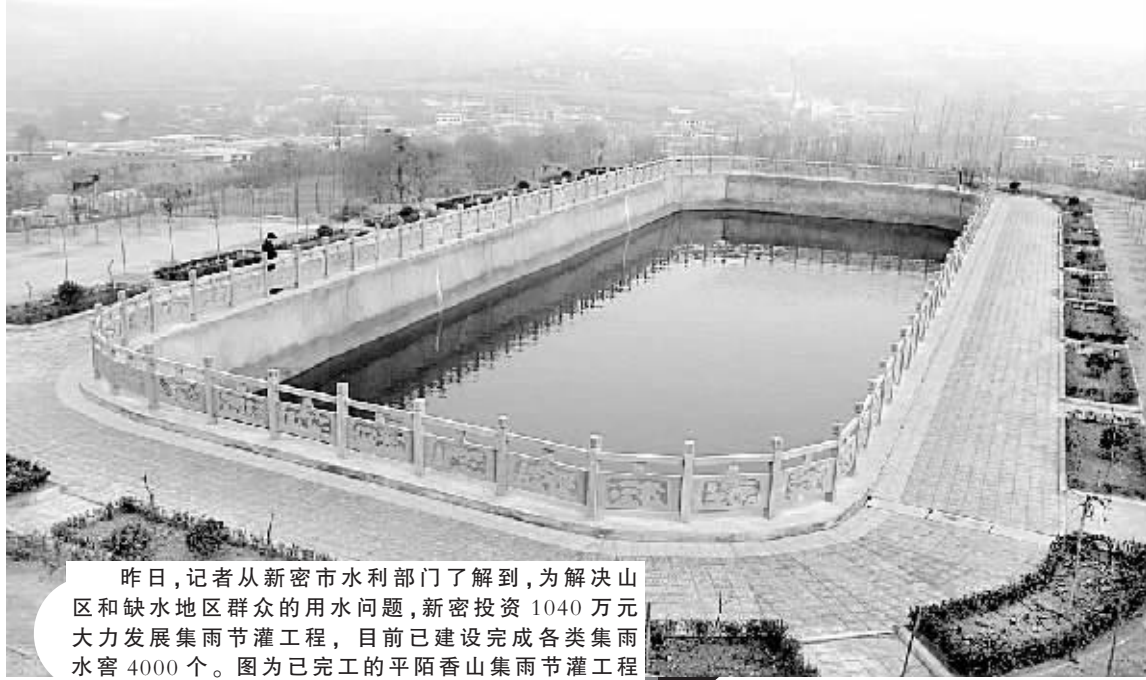
昨日,记者从新密市水利部门了解到,为解决山区和缺水地区群众的用水问题,新密投资1040万元大力发展集雨节灌工程,目前已建设完成各类集雨水窖4000个。图为已完工的平陌香山集雨节灌工程全景。本报记者 许大桥 通讯员 郭尚峰 摄
