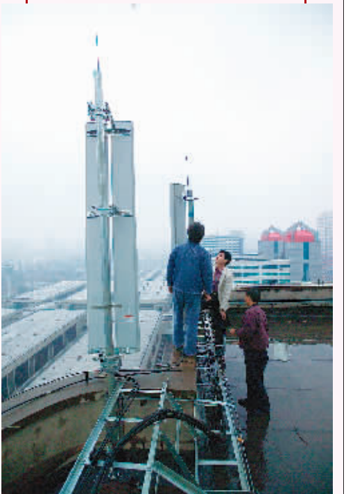
移动工作人员正在楼顶设置基站,保证信号良好。
