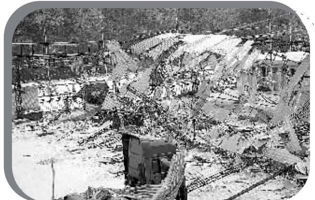
1月28日,在贵州凯里,一汽车市场的钢架大棚发生坍塌。贵州黔东南州凯里市在遭遇大面积冰凝灾害后,又遭遇一场降雪,致使部分建筑物坍塌。 新华社发
