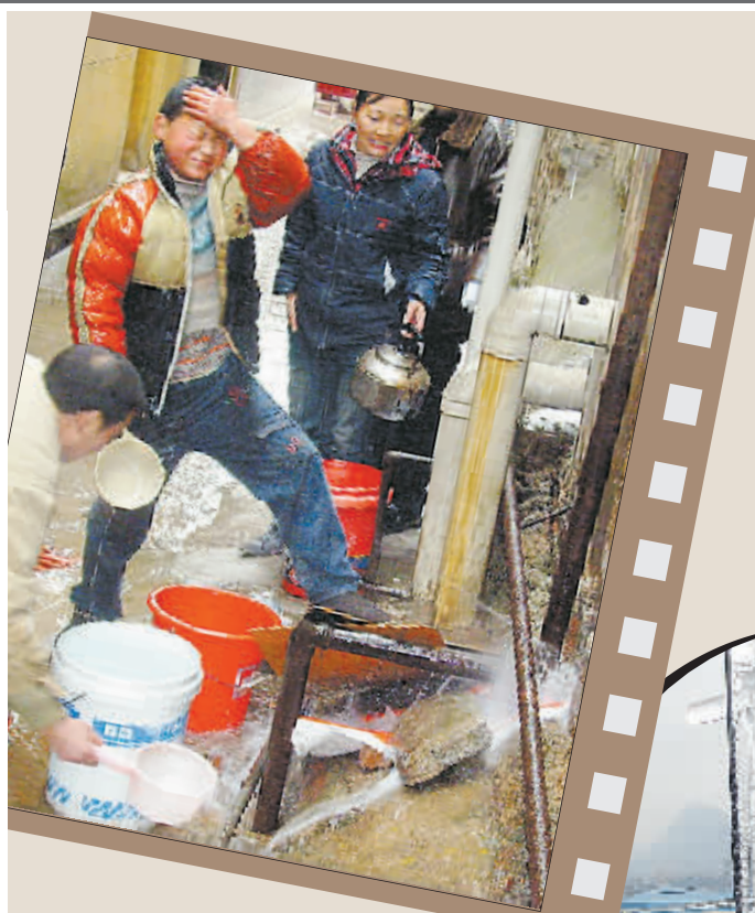
家中停水,市民只好在爆管的地方接水。
