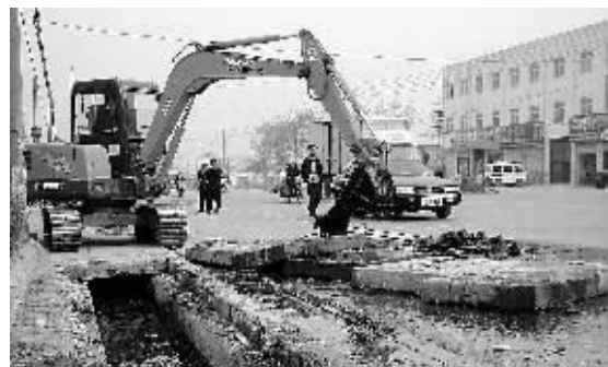
疏通南出入市口道路两旁排水系统
