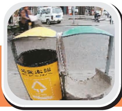
垃圾箱被损坏。
