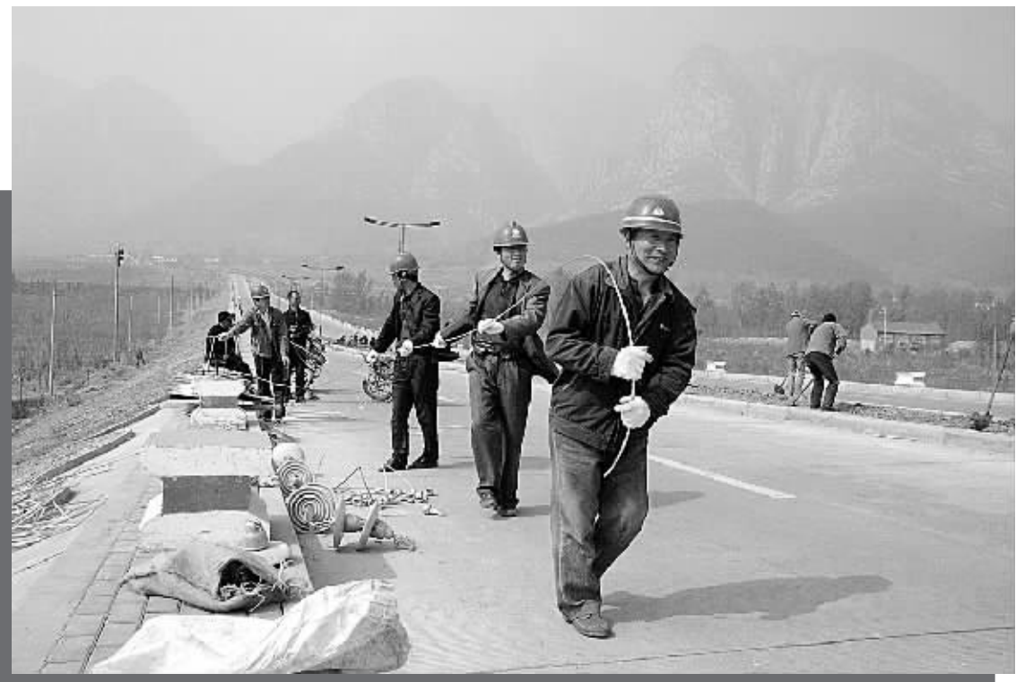
登封市电业局根据申遗的要求,近日组织30多名电工对少室阙周围用线路实行改造。截至4月7日上午,改造后的3公里线路已经完工,目前正在对2公里的老线路进行拆除。图为电工在207国道至禅宗少林·音乐大典新线路上施工。 通讯员 刘晓辉 摄
