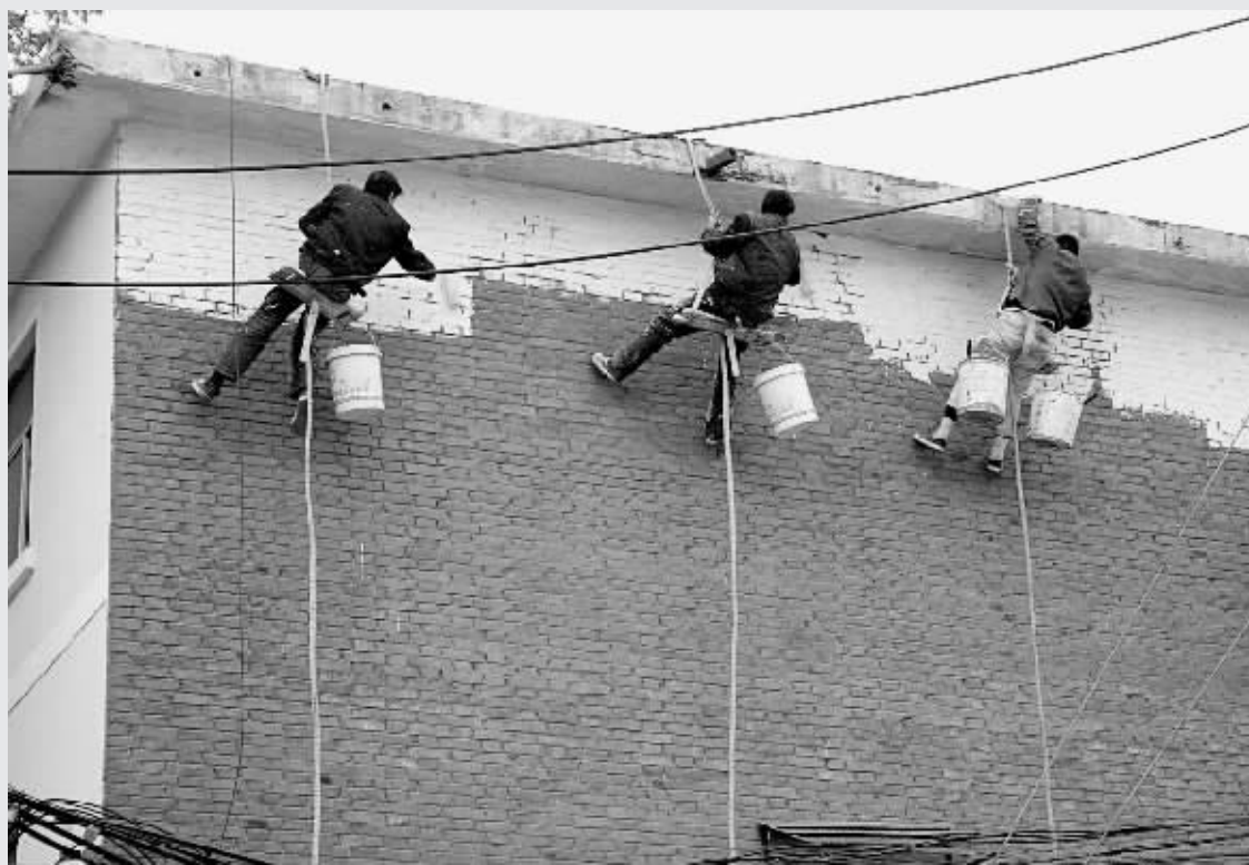
惠济区刘寨街道办事处投资 50 余万元,开展了美化、亮化工程等系列整治活动。昨日,他们请来了专业墙壁粉刷队,把南阳路两侧的破旧建筑物和围墙,共 14000 余平方米的墙壁粉刷一新。陈亚洲 刘鹏 摄
