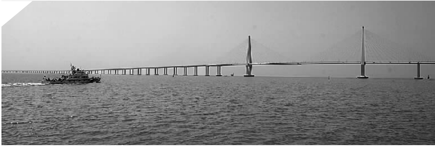
一艘海事船在杭州湾跨海大桥北岸海域巡检(4月24日摄)。新华社发
