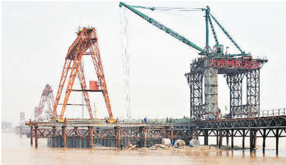
世界最长的公路铁路两用大桥——郑州黄河公铁两用大桥工程进展顺利。截至目前,大桥已完成全部钻孔桩1062根,建设承台57个,下部工程正在紧张施工中。郑州黄河公铁两用大桥是京广铁路客运专线跨越黄河的控制工程,公路铁路合建部分全长9.17公里,预计2010年建成通车。 新华社记者 赵鹏 摄
