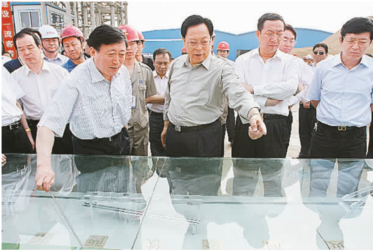
5月7日,省委书记、省人大常委会主任徐光春深入到郑州、新乡、焦作等地的重大项目建设工地和相关企业,实地察看施工建设情况,详细了解项目进度,看望慰问一线干部职工。
