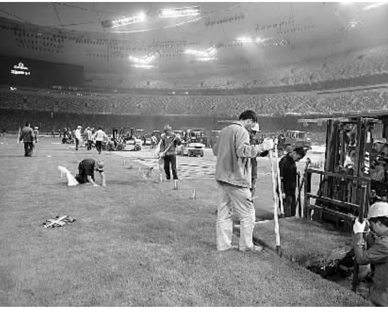
5月13日晚,北京奥运会主会场——国家体育场(“鸟巢”)开始铺草坪。据介绍,“鸟巢”草坪核心区由5460块1.159米x1.159米的草坪块组装而成,采用美国冷季型混配草种,铺好后每三天就要维护一次。
