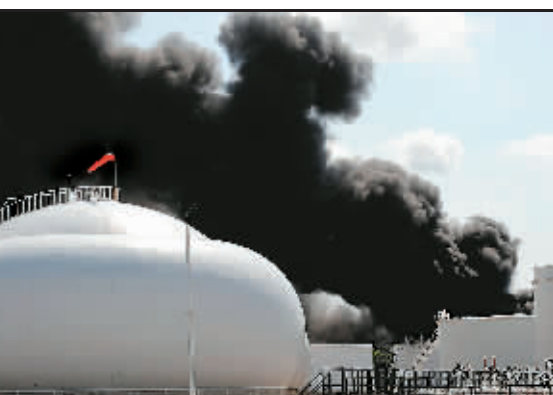
6月4日,美国堪萨斯州堪萨斯城一个油库冒出滚滚浓烟。3日傍晚,该油库的一个贮有约3万桶无铅汽油的油罐被雷电击中,随后燃起熊熊大火。 均为新华社发
