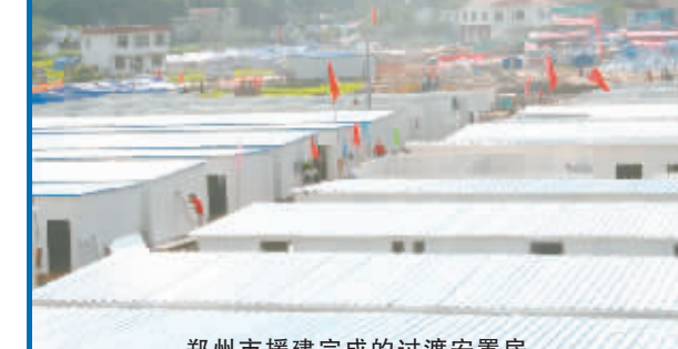
郑州市援建完成的过渡安置房
