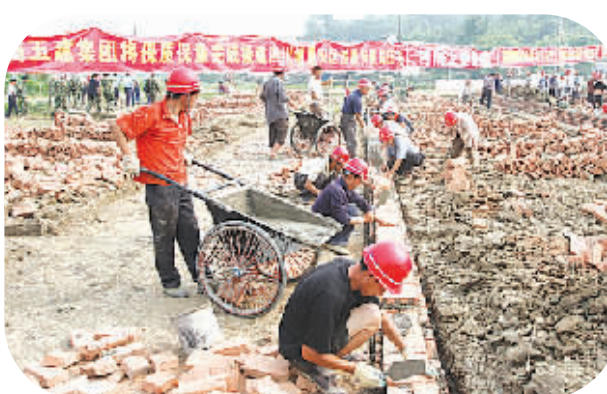
郑州建设工人正在四川安县晓坝镇紧张施工
