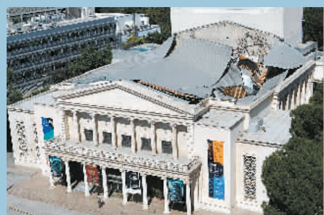
这张摄于6月12日的照片显示的是塞浦路斯首都尼科西亚的一座屋顶坍塌的剧院。这座塞浦路斯最大的剧院在11日晚间发生屋顶坍塌,所幸当时并无人员在内。目前塞浦路斯政府已对该事件展开调查。 新华社/路透
