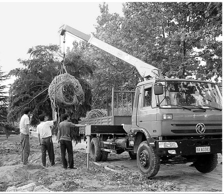
为了配合黄郭路与嵩山路交叉立交的试桩工程,二七区绿化管理所将入市口嵩岳公园施工占地 500 余株雪松、黄杨球、月季等植物移植到其他游园。
