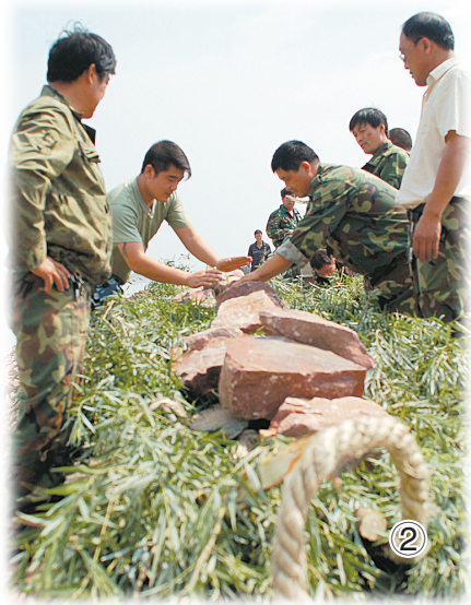
①加固险工段河堤。 ②③制作防汛固堤的“柳石枕”。 ④打桩。 ⑤紧张的防汛演练现场。
