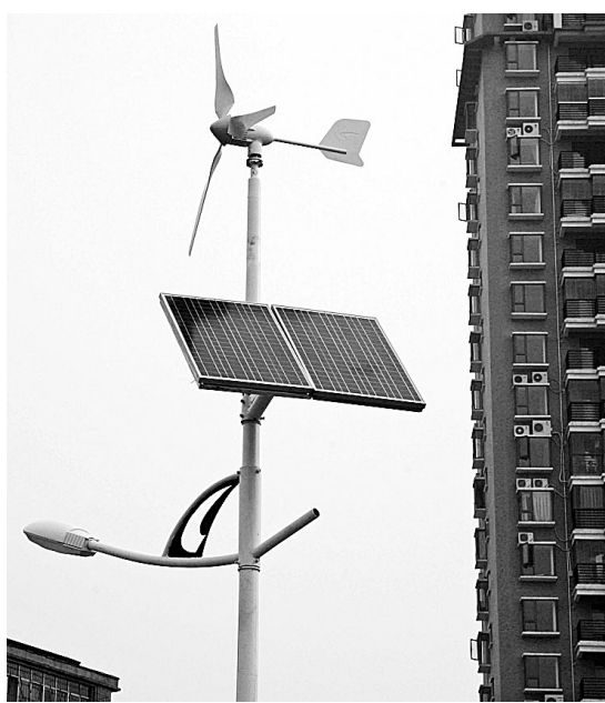
4日,“风光互补”型路灯在襄樊市沿江大道亮相。近日,一种利用太阳能和风能的“风光互补”型路灯在襄樊街头投入使用。据了解,这种新型路灯利用自然界的风能和太阳能双系统供电,在蓄电池电量充足的情况下,即使没有能源的补给,也能连续工作5个晚上。 新华社发
