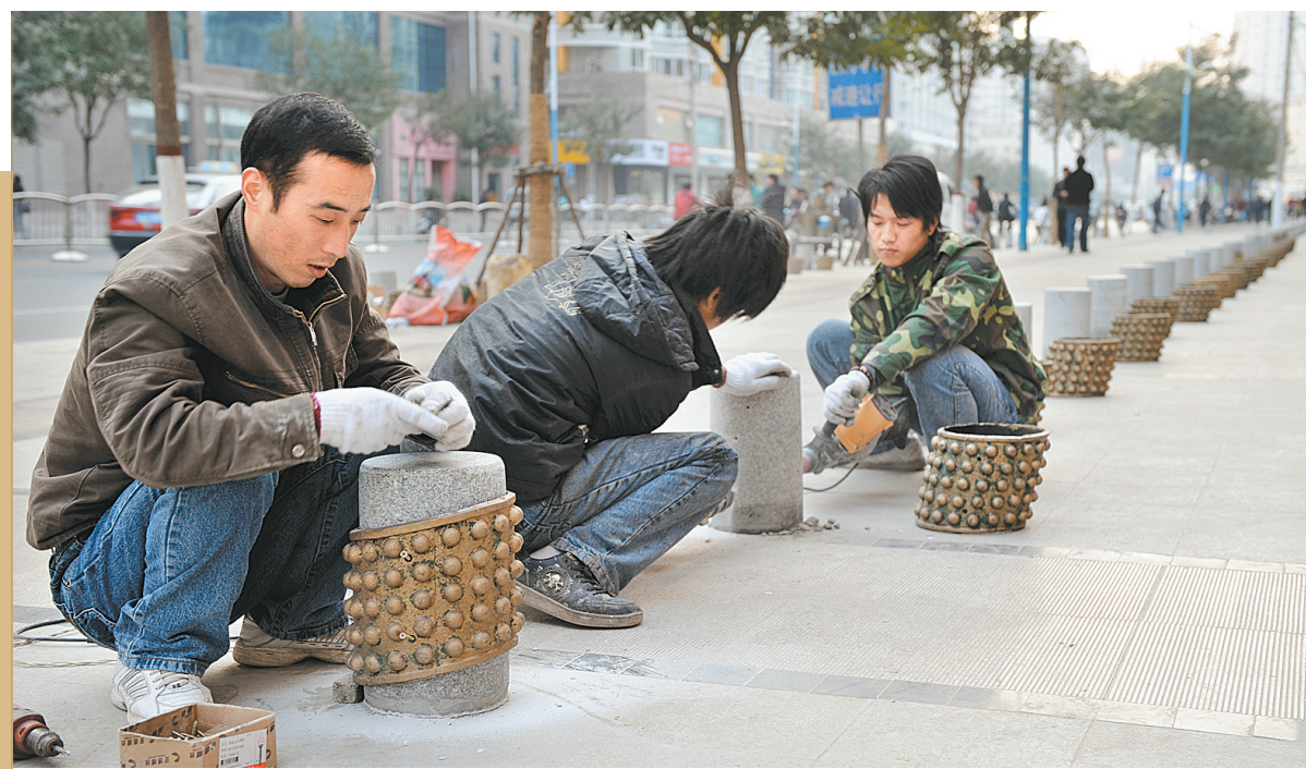
昨日下午,东西大街旁的人行道上,施工人员正在给新装的石砌加装古铜色铸铁外壳。连日来,我市在嵩山路、东西大街等精品街的人行道安装了一排排圆柱体石砌。为了体现郑州悠久的历史和文化,使石砌外观同商城区更加协调,工程技术人员又在石柱外面套装了仿青铜器铸铁外壳。
