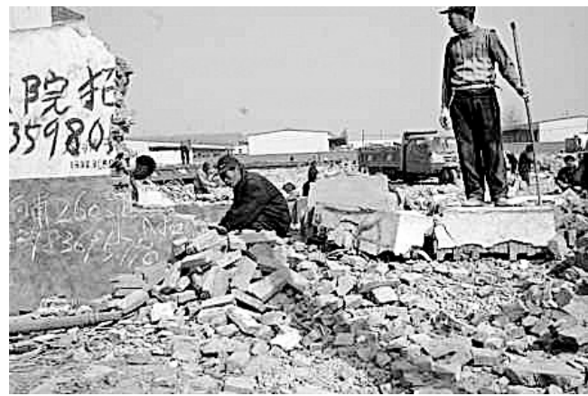
二七区开展集中整治违法用地违法建设行动,昨日,嵩山路街道办事处贾砦社区部分村民,对位于郑平路东18.72亩土地上形成的7250平方米违章建筑物,进行了自行拆除。本报记者 李焱 摄
