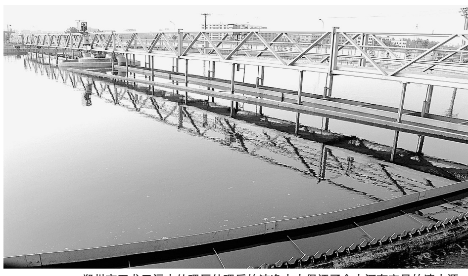
郑州市五龙口污水处理厂处理后的洁净水保证了金水河有充足的水源。
