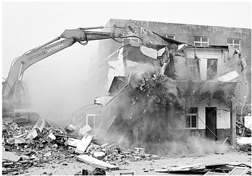
本报讯(记者安群英 通讯员 阎安生 王天明)昨日,二七区侯寨乡最大的一宗违法用地建筑,在钩机和铲车的轰鸣声中轰然倒地。
