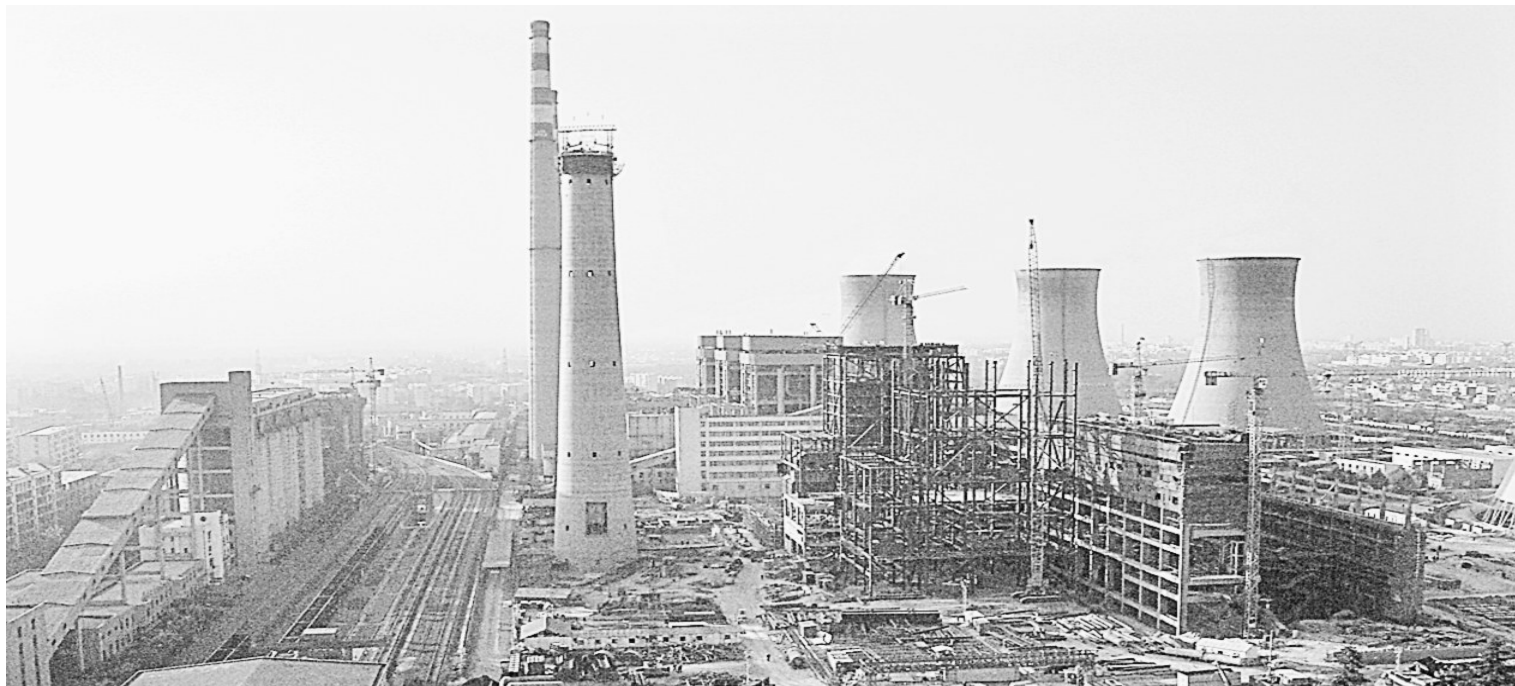
建设中的郑州热电厂。
