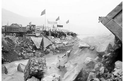
12月28日上午11时26分,随着最后一车渣土倒入向家坝水电站大江合龙口中,中国第三大水电工程向家坝水电站成功实现大江截流。
