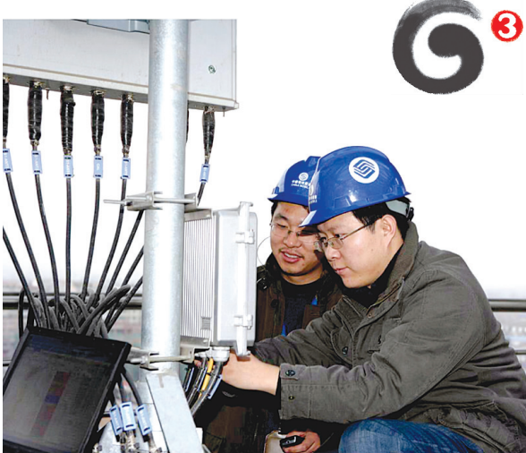
工程技术人员正在郑州市区调测TD设备
