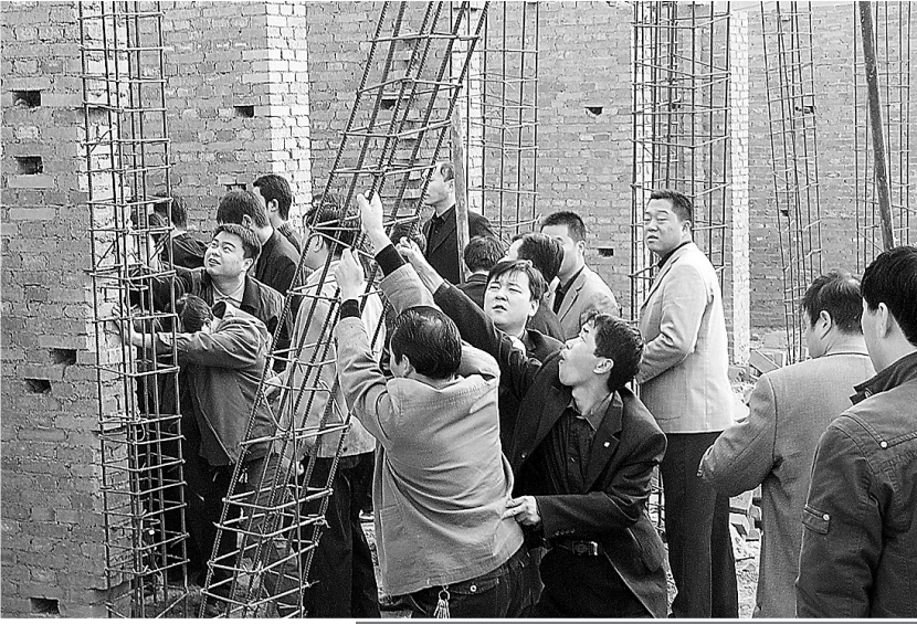
拆除登封市区违法建筑。
