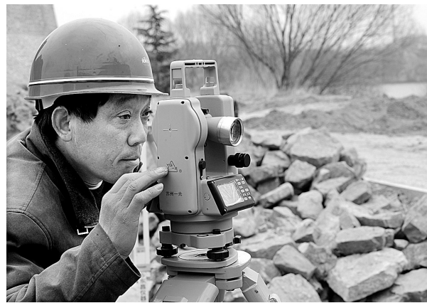
昨日上午,一位工程技术人员在尖岗水库除险加固工程溢洪道进水渠施工现场作业。该工程建设设计洪水标准为100年一遇。
