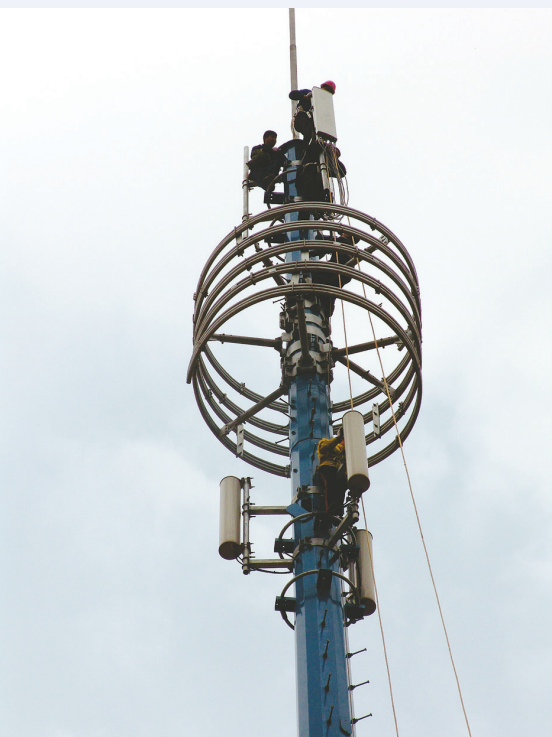
郑州移动工程技术人员正在基站顶部安装调试设备
