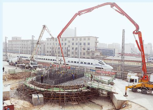
本报讯(记者 裴其娟 实习生 席宁华 文 李利强 图)昨日,郑州中心区铁路跨线桥技术难度最高的施工环节——转体系统上转盘实施混凝土灌注,标志着该桥即将进入斜拉桥主桥建设阶段。
