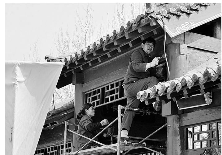
昨日上午,在拜祖广场四周的长廊上,施工人员正在为建筑物刷油漆。
