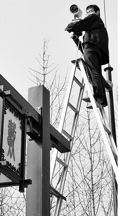
施工人员在百家姓广场加装视频监控设备。
