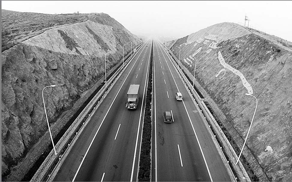
郑少高速公路建成通车,为我市旅游业和地方经济发展起到了巨大的推动作用。 本报记者 许大桥 摄
