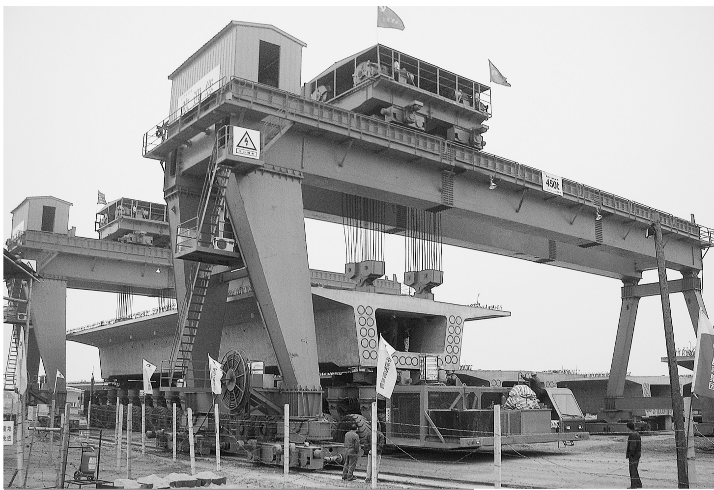
三年来,我市涌现大量创新科技成果。图为施工中的大方2×450吨轮轨式提梁机装车。
