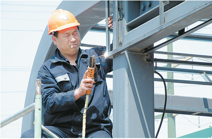
施工人员在现场紧张工作。
