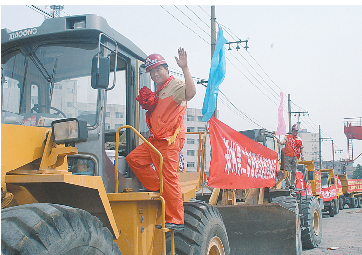
施工突击队奔赴灾区。
