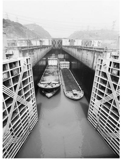
5月21日,货轮通过三峡船闸下行。随着主汛期临近,5月21日,三峡坝上水位为154.4米,满足三峡五级连续船闸四级运行的水位条件,长江三峡通航管理局首次将船闸南北两线的运行方式由五级转为四级,船闸过闸时间缩短40分钟左右。 新华社发
